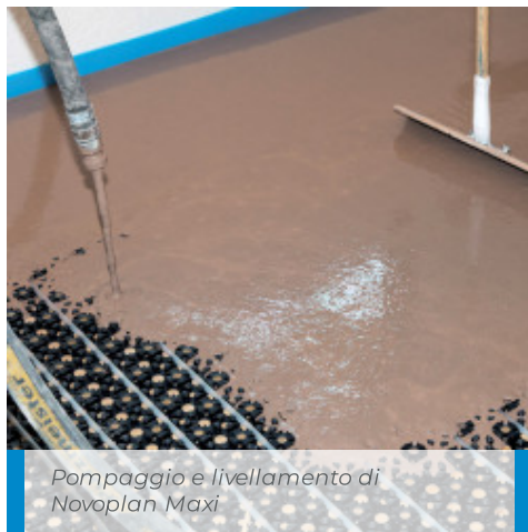
Stesura dell'impasto a saturazione dell'impianto radiante a basso spessore
