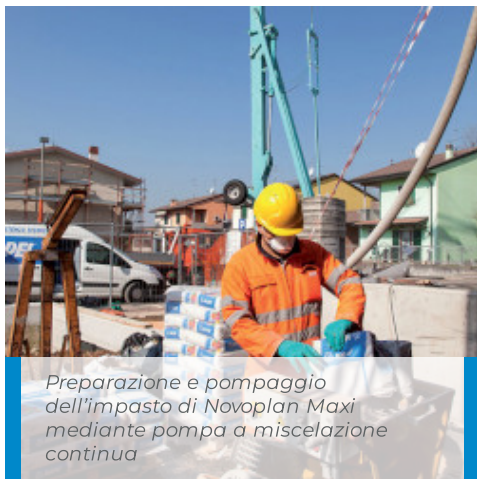
Pompaggio e livellamento di Novoplan Maxi
