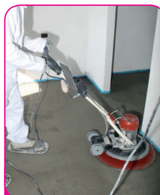
IL MASSETTO VIENE RIFINITO CON MACCHINA ROTANTE CON POCA O SENZA ACQUA IN BASE ALLA TEMPERATURA ESTERNA
