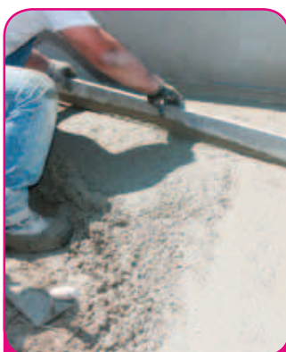
IL MASSETTO VIENE POMPATO AL PIANO E STAGGIATO AL LIVELLO DESIDERATO
