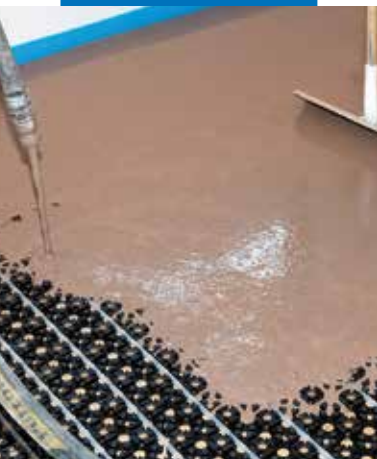
Pompaggio e livellamento di Novoplan Maxi
