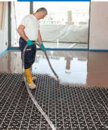
Stesura dell'impasto a saturazione dell'impianto radiante a basso spessore
