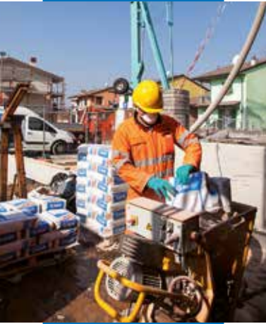
Preparazione e pompaggio dell'impasto di Novoplan Maxi mediante pompa a miscelazione continua
